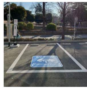
▲EV充電スタンド
